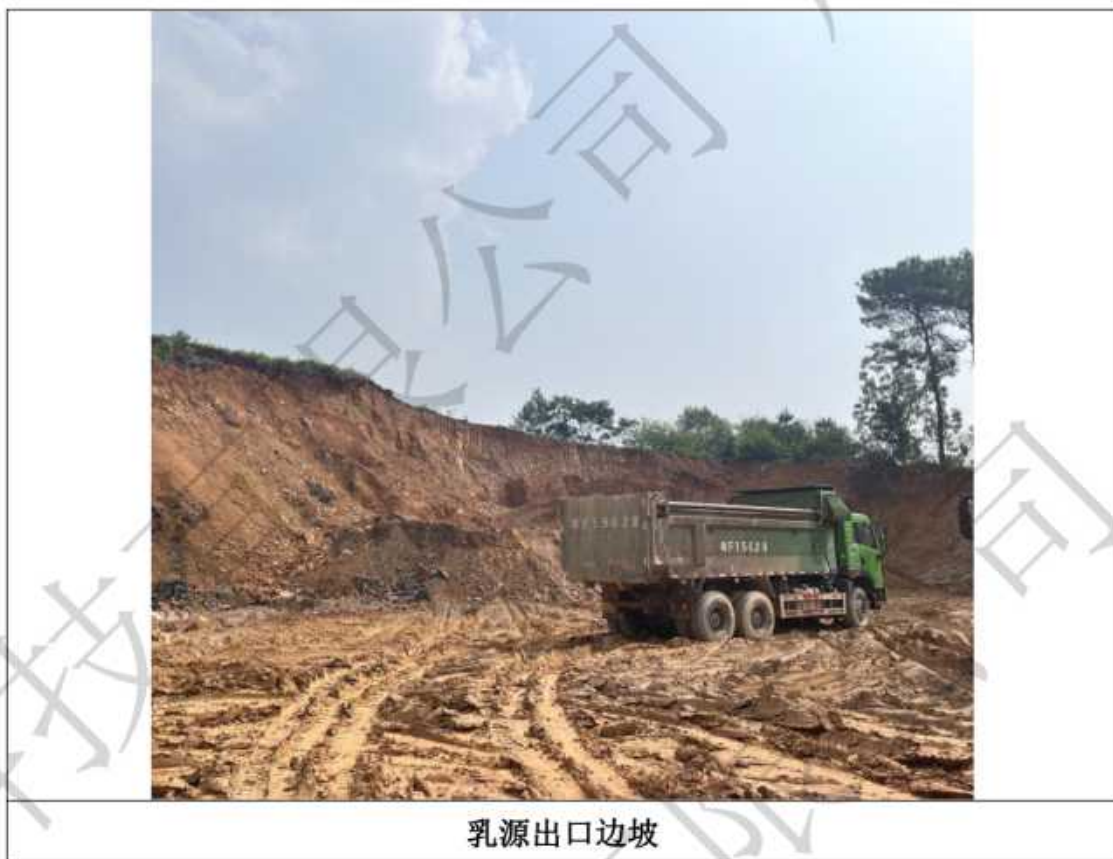
图 4.3-1 覆土来源山坡现场踏勘图
