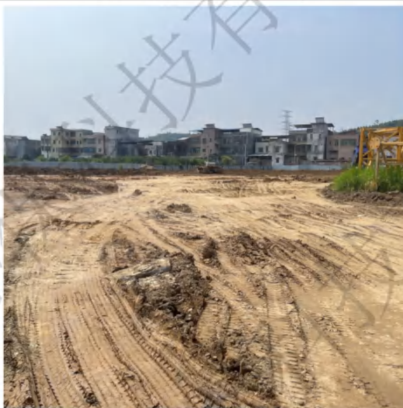
地块内现状（平整中）
